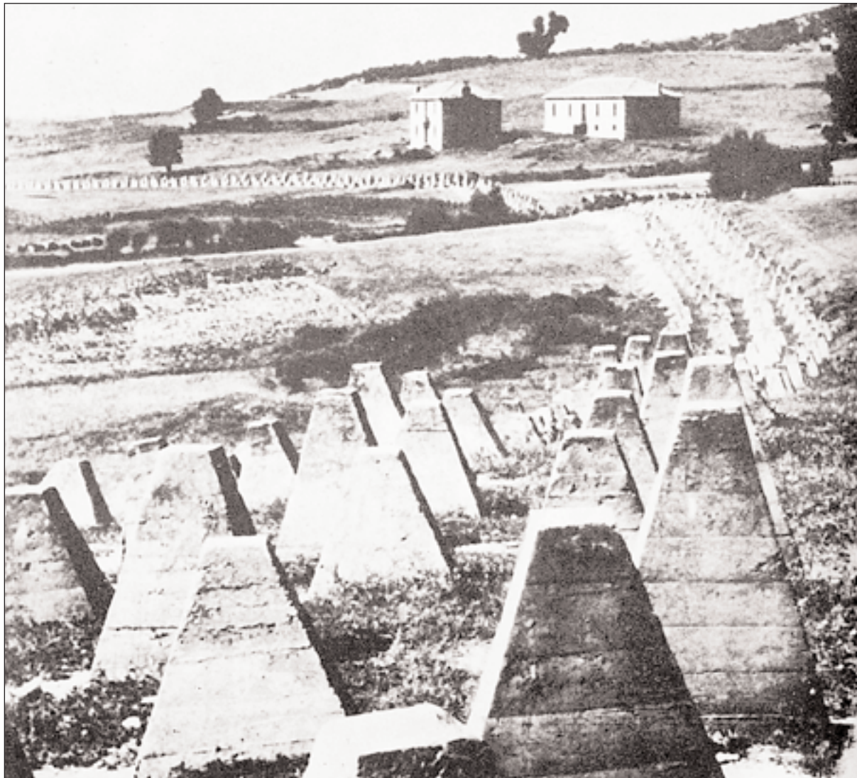
▲ Συνδυασμός αντιαρματικών κωλυμάτων από πεσοούς σκυροδέματος στη «γραμμή Μεταξά».
