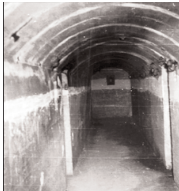
► Στοά συγκοινωνίας στο έργο Ουόιτα των οχυρών Ρούπελ.
