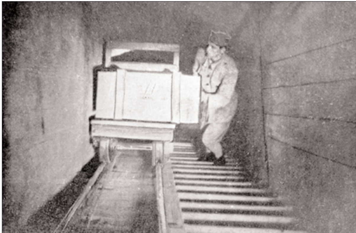
▲ Μεταφορά πυρομαχικών σε πυροβολείο πλαγιοφέλαξης. Οι αποθήκες πυρομαχικών βρίσκονταν στους υπόγειους χώρους των πυροβολείων και τα πυρομαχικά μεταφέρονταν με ειδικό καρότσι που κινούνταν σε σιδηροτροχιές πλάτους 45 εκατοστών. Στη «γραμμή Μαζινό» η διαδικασία ήταν αυτοματοποιημένη και τα πυρομαχικά μεταφέρονταν με ηλεκτροκίνητα βαγονέτια και ανελκυστήρες.
