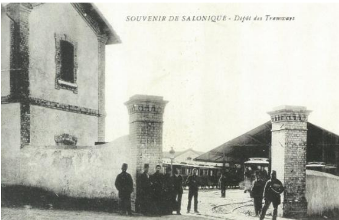
Αποθήκη Τροchioδρόμων (Depot)
