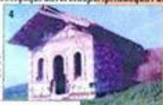
4. Ο σταθμός και μεταφορικό Σταθμός στο Δασικό Κερατσία
