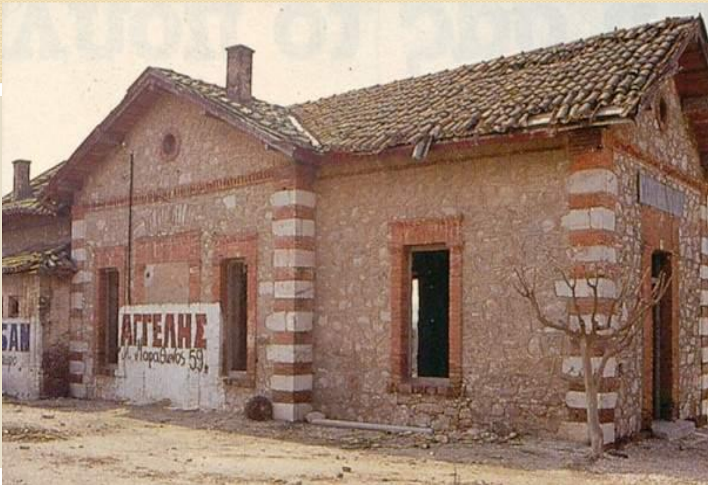
Ο σταθμός στο Μαρκόπουλο- τυπικό παράδειγμα Σιδηροδρομικής Βιομηχανικής Αρχιτεκτονικής.
