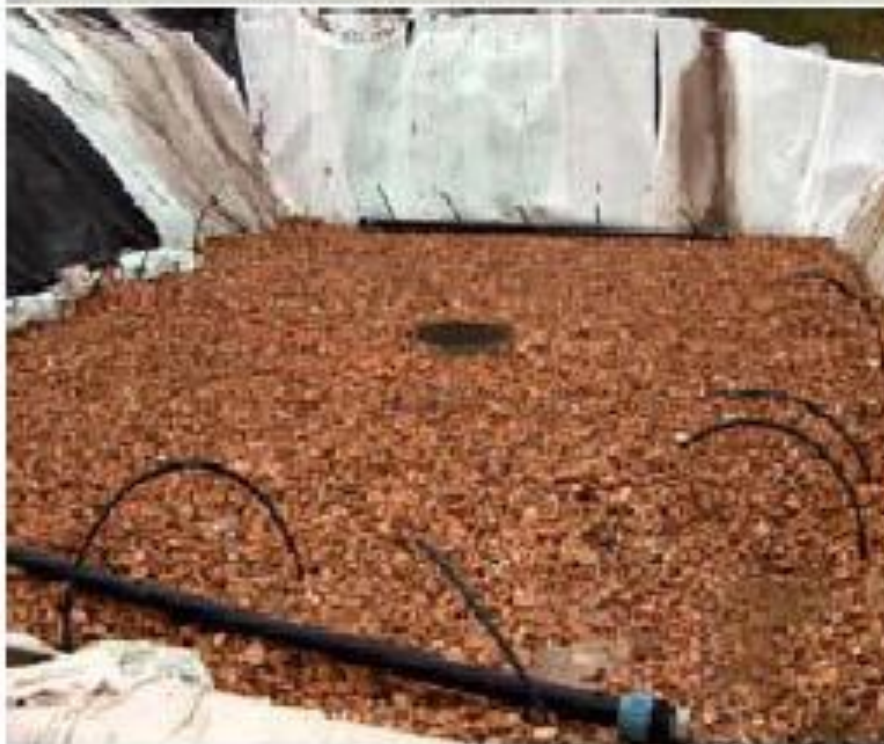
Εικόνα 6. Απεικόνιση της τεχνολογίας υπεδάφιας διάθεση υγρών αποβλήτων ελαιολιτριβείου με το σύστημα OLEICO (με πλήρη προστασία του υδροφόρου).
