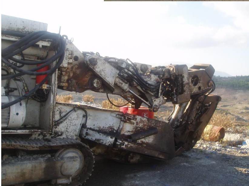
Μηχάνημα για τη διάνοιξη σήραγγας
