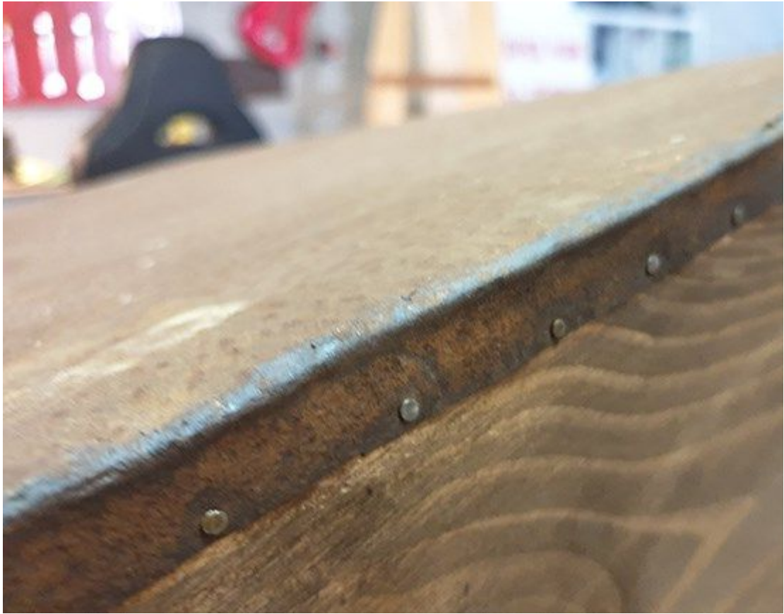
Διακρίνονται τα καρφιά που έχουν τοποθετηθεί με μεγάλη προσοχή στο σίδερο και στο ξύλο στις ήδη υπάρχουσες τρύπες (από τα παλιά καρφιά)
