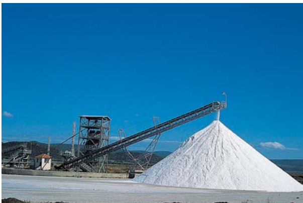
Εικόνα 19: Εγκαταστάσεις πλύσης και απόθεσης άλατος - Καλλονή
