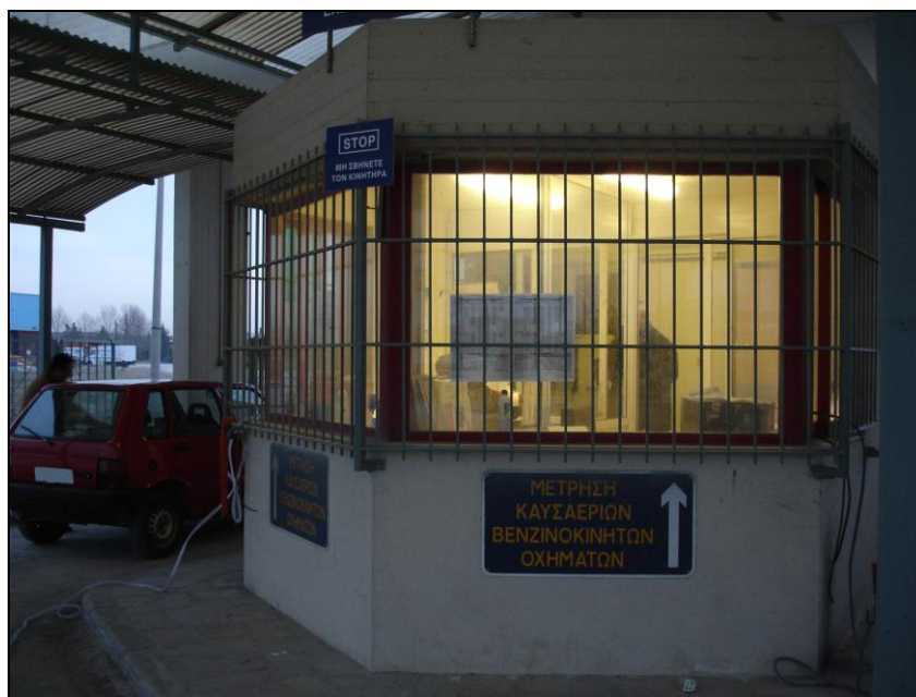
Εικόνα 59: Είσοδος στο ΚΤΕΟ και έλεγχος καυσαερίων.
