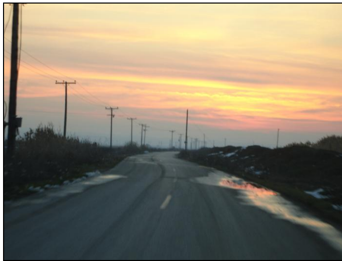
Εικόνα 81: Τυπική περίπτωση επαρχιακού δρόμου και των σταθερών σημείων (στύλοι) που ακολουθούν το ανάγλυφό του.
