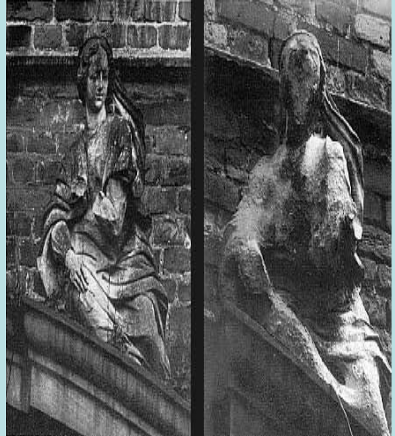
Ένα γλυπτό στον πύργο Χέρτεν στη Βεσφαλία της Γερμανίας μοιάζει μ' ένα κομμάτι πέτρα χωρίς σχήμα. Μια του φωτογραφία από το 1908 δείχνει ένα περίτεχνο άγαλμα κοριτσιού.
