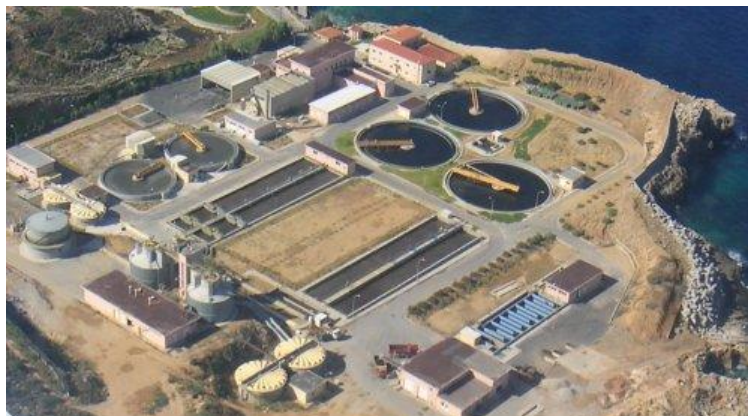
μονάδα επεξεργασίας νερού.
