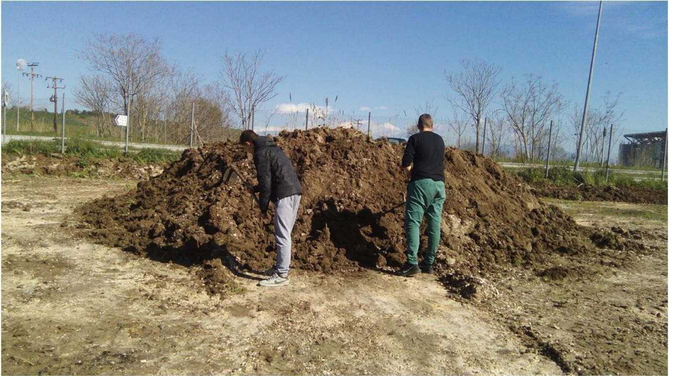
Οι μαθητές αρχίζουν την κατασκευή του βραχόκηπου.
