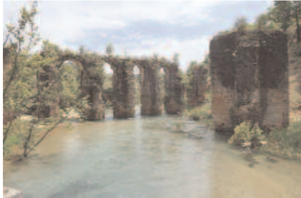
Εικόνα 10. ΡΩΜΑΪΚΟ ΥΔΡΑΓΩΓΕΙΟ ΣΤΟΝ ΑΓΙΟ ΓΕΩΡΓΙΟ
