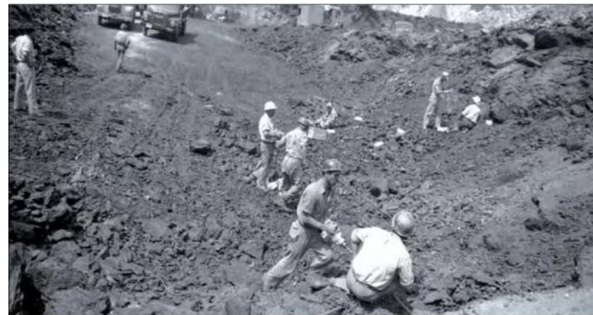
Επιφανειακό μέτωπο εξόρυξης λιγνίτη. | Surface front of lignite excavation.
