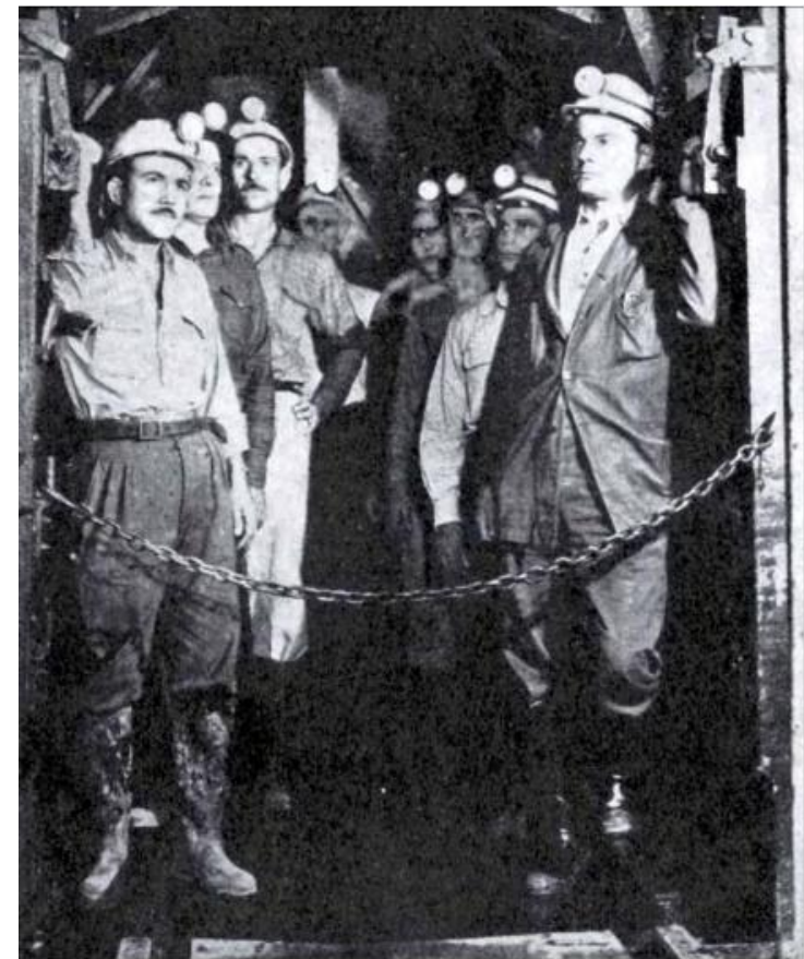
Μηχανικοί, επίβλεπες και λιγνιτωρύχοι στον ανελκυστήρα οριζόντιου του βελώνης προς τα εμπρός και από εκεί στο μέτωπο εξόρυξης
