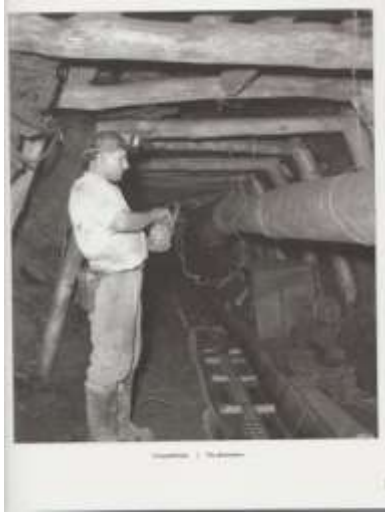
7.Πυροδότηση-λιγνιτωρυχείο Αλιβερίου πριν την πυροδότηση φωνάζει «Βάρδα Φουρνέλο» Εργασίες υποστήριξης στοάς (Φωτογραφικό αρχείο ΔΕΗ)
