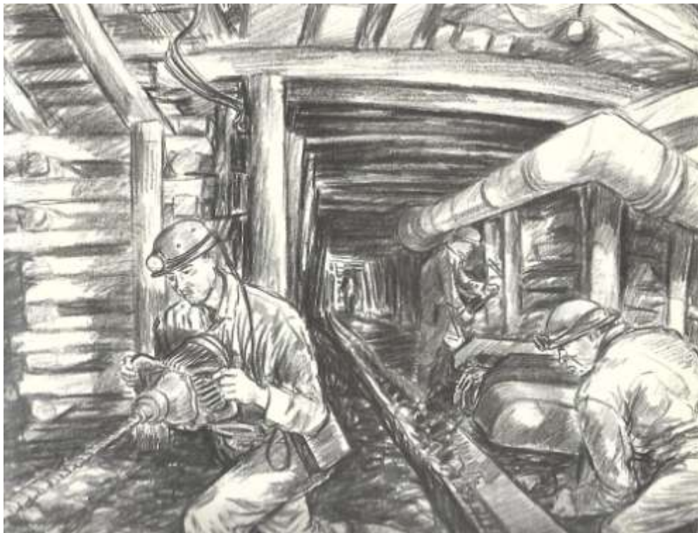
71.Υποστήριξη υπόγειας στοάς από τους μποσκαδόρους για την κατασκευή στύλων και πλαισίων- λιγνιτωρυχείο Αλιβερίου(σχέδια Μεγαλίδη)
