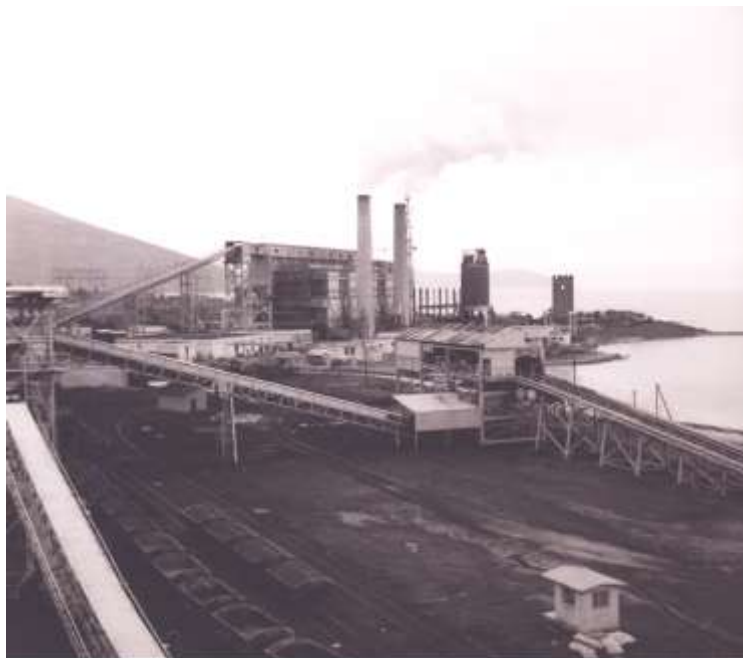
20.ΑΗΣ 1 η Μονάδα στο βάθος ενετικός πύργος (Φωτογραφικό Αρχείο ΔΕΗ)
