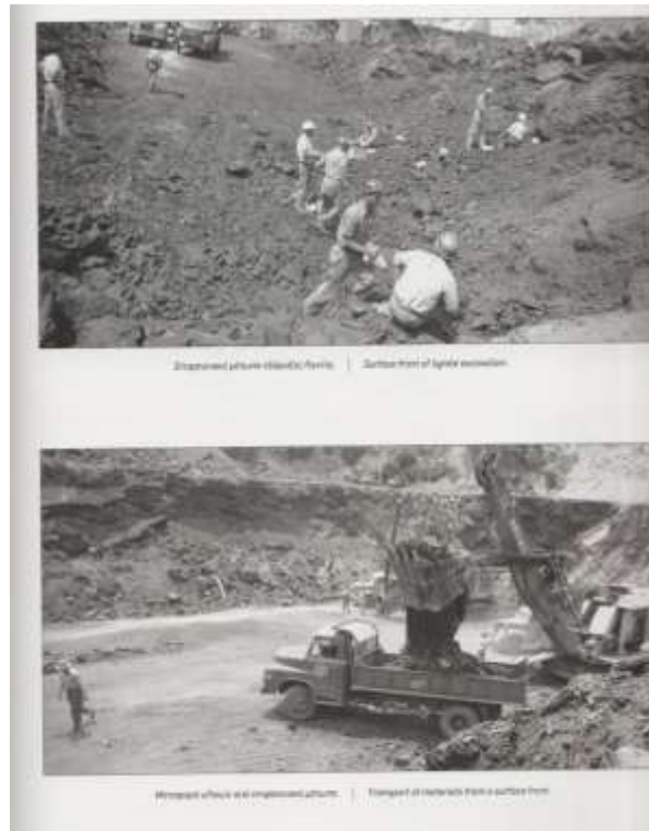
29.Επιφανειακό μέτωπο εξόρυξης λιγνίτη και μεταφορά υλικών από επιφανειακό μέτωπο (Αλιθέρι), (φωτογραφικό αρχείο ΔΕΗ)
