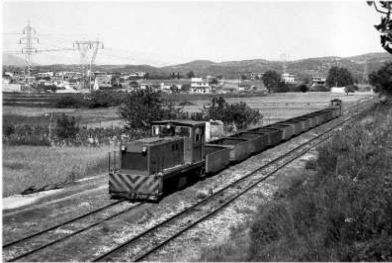
26. Το τρένο μεταφοράς λιγνίτη από το λιγνιτωρυχείο Μπρινιά στον ΑΗΣ Αλιβερίου στον Κάραβο (αρχείο ΔΕΗ)
