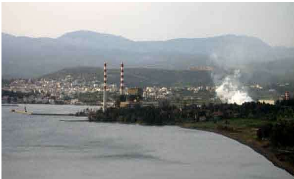
86.ΔΕΗ με τη νέα μονάδα παραγωγής με Φυσικό αέριο στο σημείο που φαίνεται η διαρροή ατμού. Στο βάθος η πόλη του Αλιβερίου ( http://www.greekarchitects.gr .Αναστασία Πεπέ,12 Μαΐου, 2013)
