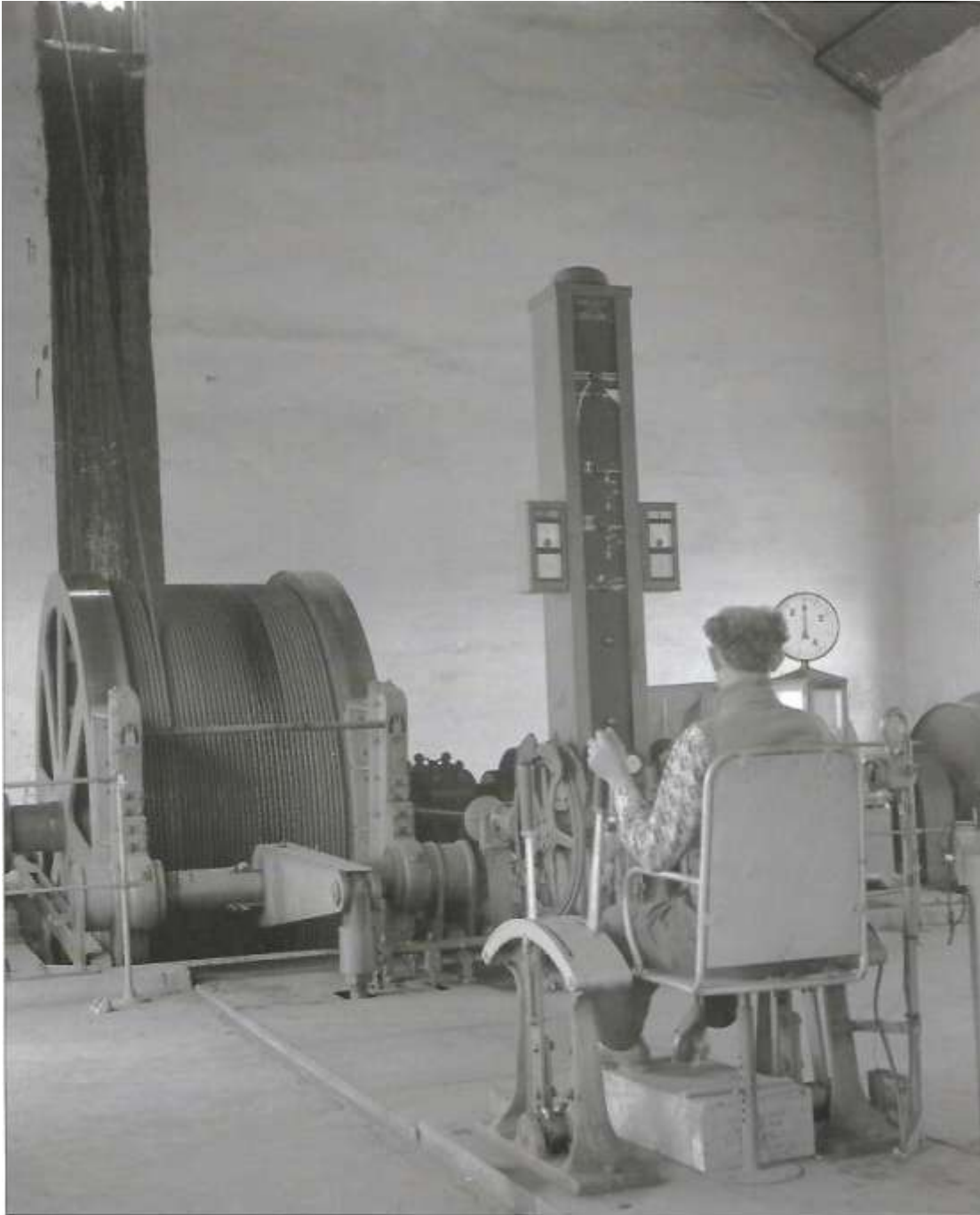
68.Ο χειριστής βαρούλκου ανεβοκατεβάζει τον ανελκυστήρα στις στοές (ΔΕΗ,Λεύκωμα,60 χρόνια ενέργεια στην Ελλάδα,1950-2010)
