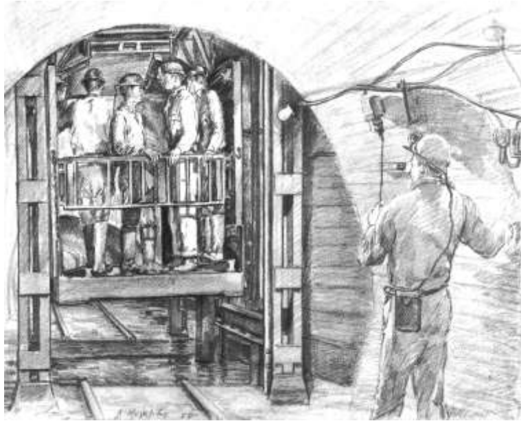
34.Επιστροφή των λιγνιτωρύχων στην επιφάνεια στο τέλος της βάρδιας. Ο κλωθός τους ανεβάζει στην επιφάνεια του εδάφους (ΑΛΙΒΕΡΙ-Λιγνιτωρυχείο, Ελαιογραφίες- σχέδια Δημήτρη Μεγαλίδη, Αθήνα 1960)
