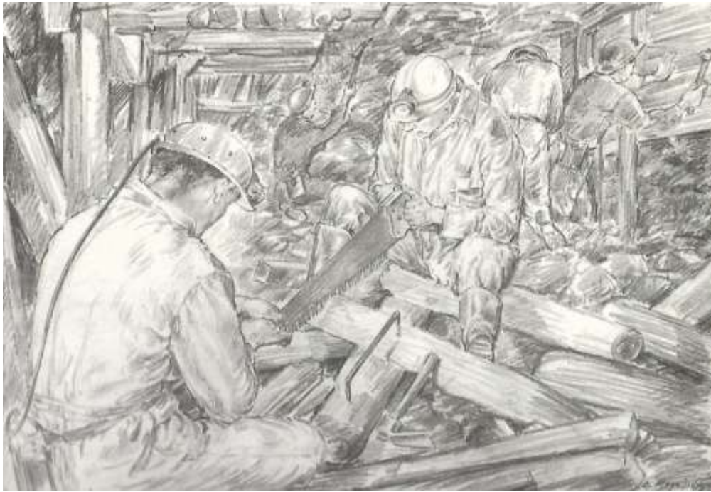
71.Υποστήριξη υπόγειας στοάς από τους μποσκαδόρους για την κατασκευή στύλων και πλαισίων- λιγνιτωρυχείο Αλιβερίου(σχέδια Μεγαλίδη)
