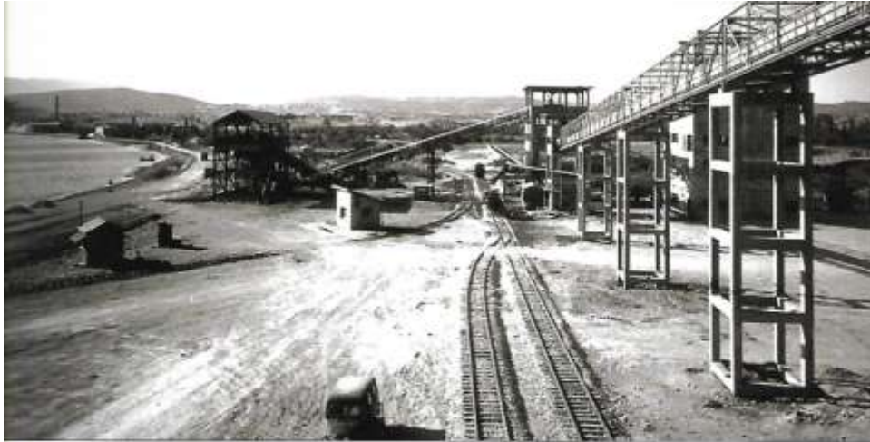
Υπόγεια μεταφορικά μέσα. Δεξιά ο ταινιόδρομος και δίπλα του ο σιδηρόδρομος. | Surface means of transportation. The conveyor belt to the right and the railway to the left.
