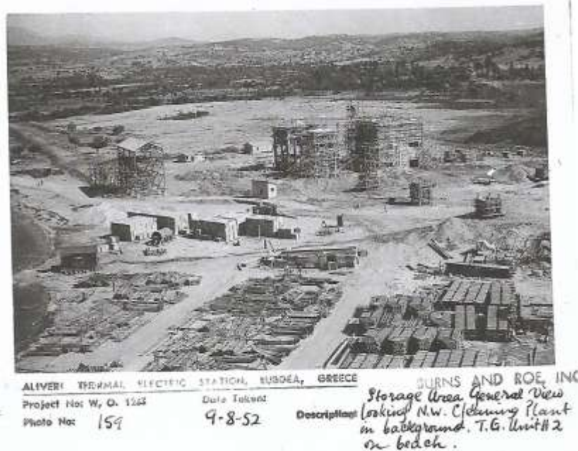
58. Έργα κατασκευής ΑΗΣ, στο βάθος το Αλιβέρι 1952 (αρχείο Burns and Roe)
