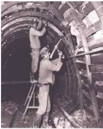
7.Πυροδότηση-λιγνιτωρυχείο Αλιβερίου πριν την πυροδότηση φωνάζει «Βάρδα Φουρνέλο» Εργασίες υποστήριξης στοάς (Φωτογραφικό αρχείο ΔΕΗ)
