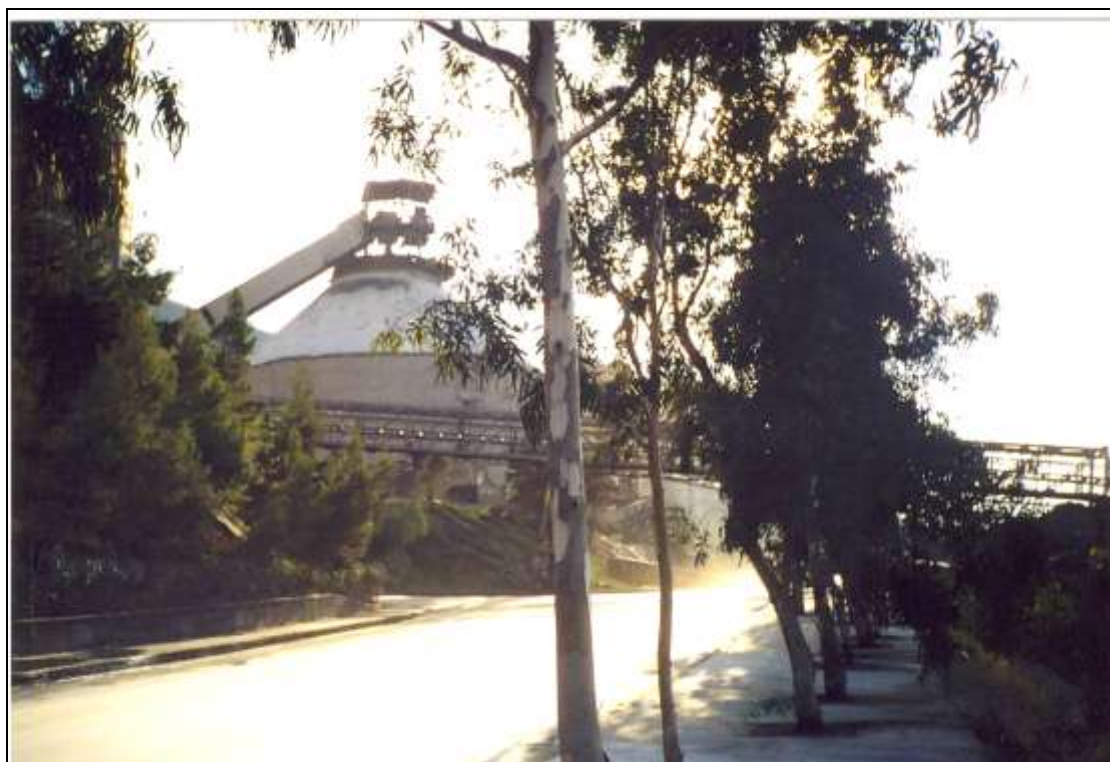
ΣΙΛΟ ΤΣΙΜΕΝΤΟΥ ΚΑΙ ΤΕΝΙΟΔΡΟΜΟΣ
