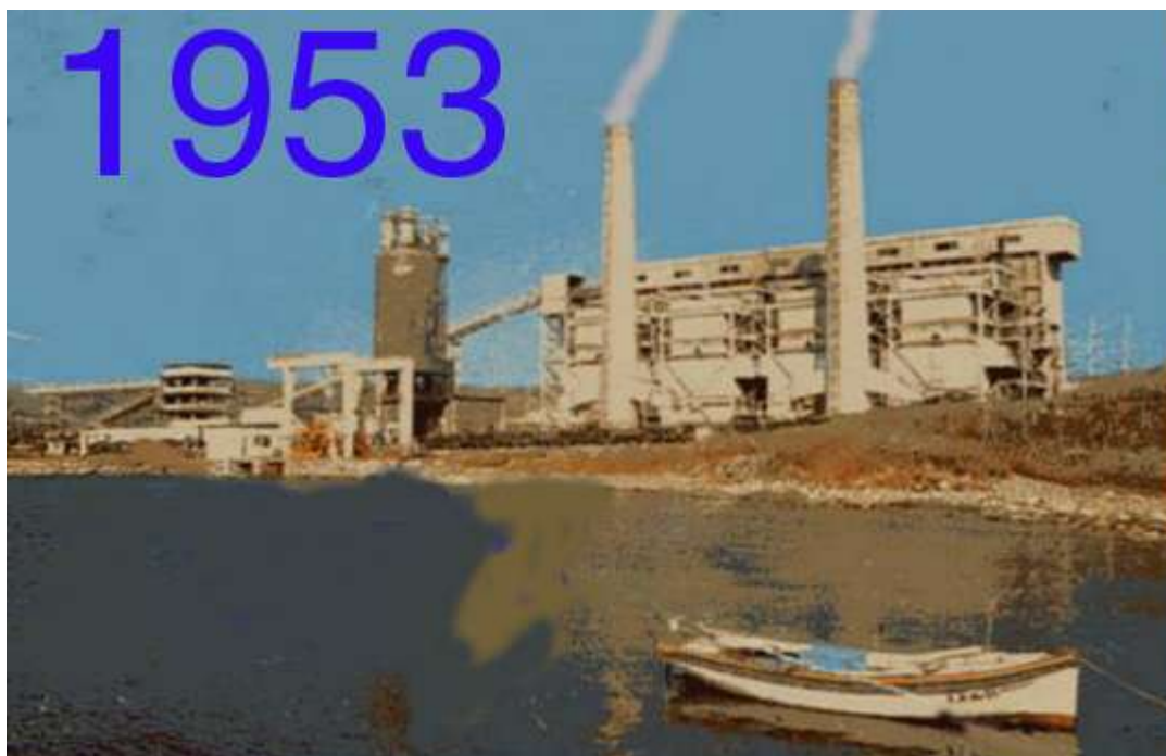
Αλιβέρι 1953 - Λειτουργεί ο πρώτος θερμοηλεκτρικός Σταθμός στην Ελλάδα ( φωτογραφία από το αρχείο της ΔΕΗ )
