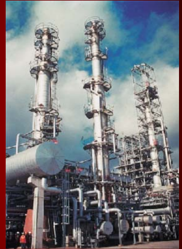
Πύργος Κλασματικής απόσταξης σε διυλιστήριο πετρελαίου. (Κάθε πύργος είναι περίπου 30 μέτρα ύψος.)
