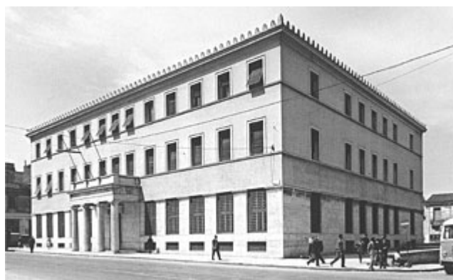
Το Δημαρχείο πριν την κατασκευή του τρίτου ορόφου και μετά
