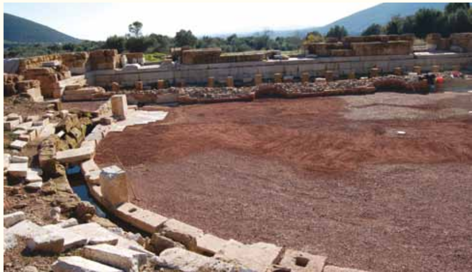
εικ. 50 Οπές για τη στήριξη κιγκλιδώματος γύρω στην ορχήστρα.
