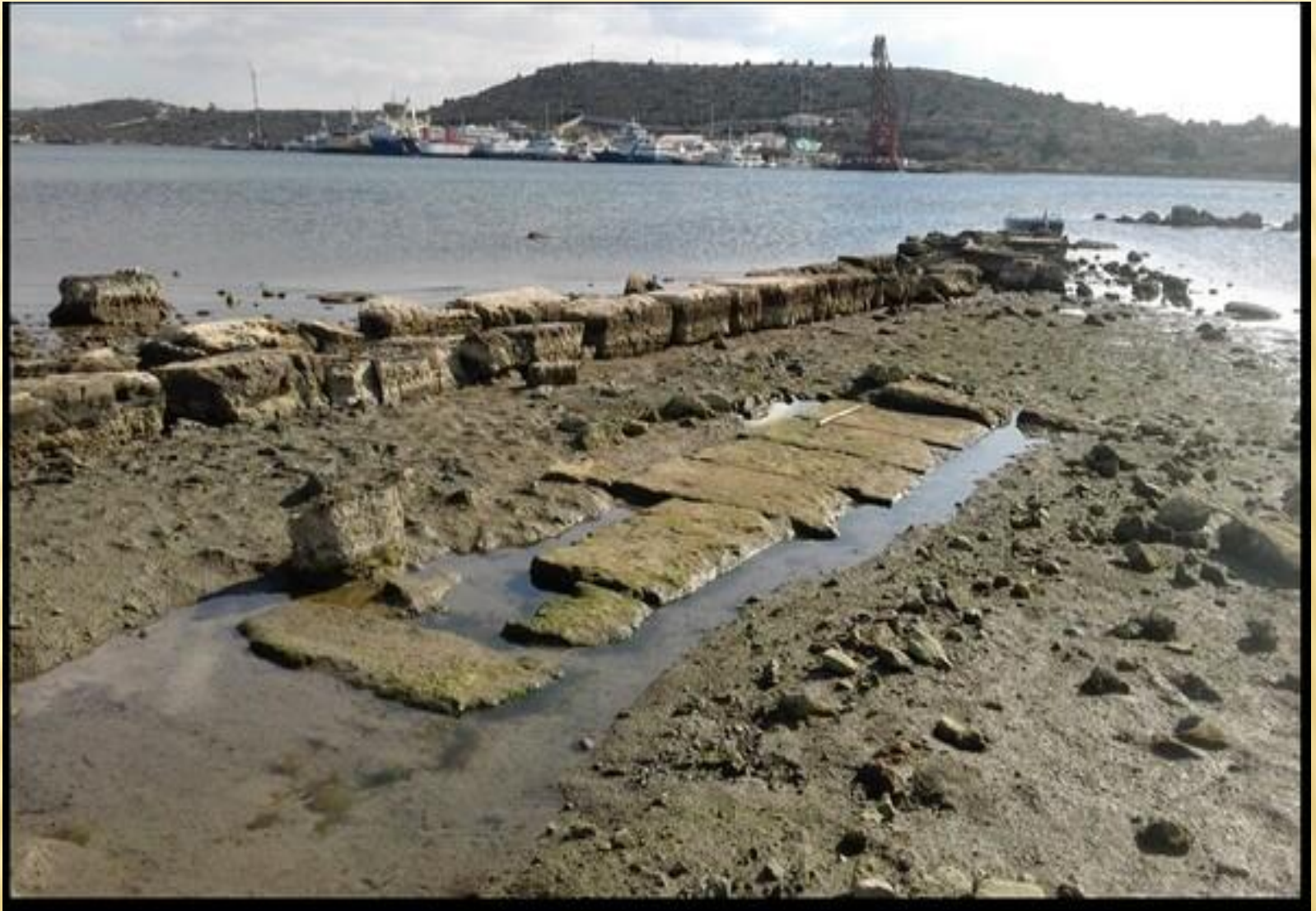
Σαλαμίς. Τμήμα θεμελίωσης στιβαρής κτηριακής ή άλλης κατασκευής της Κλασικής περιόδου, δίπλα σε νεώτερο μώλο από αρχαίο δομικό υλικό, στην βόρεια πλευρά του Όρμου του Αμπελακίου (Φωτογρ. Χρ. Μαραμπέα).
