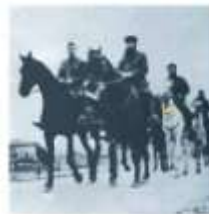
Ανατίναξη γέφυρας Γοργοπόταμου Νοεμβρίου 1942
