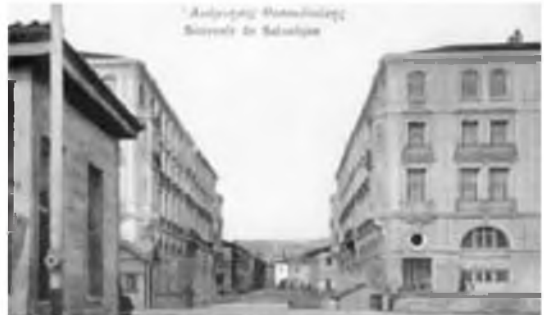
Κτίρια γραφείων της Γαλλικής Εταιρείας Κατασκευής και Εκμετάλλευσης Λιμένος. Βρίσκονταν στην οδό Σαλαμίνας
