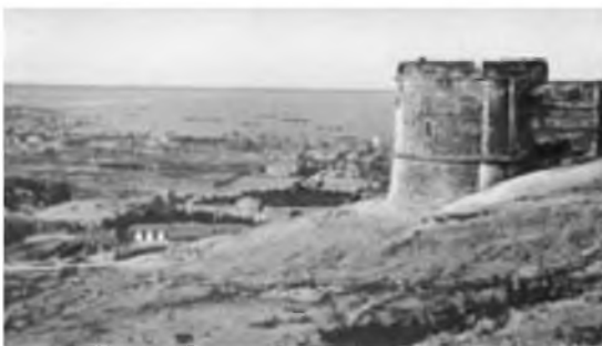
Άποψη του εκτός των ανατολικών τειχών χώρου
