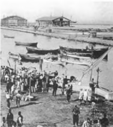
Λιμάνι: Έργα επέκτασης
