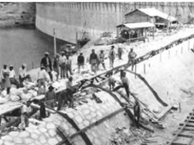
Εργοτάξιο στο φράγμα του Μαραθώνα, 1928
