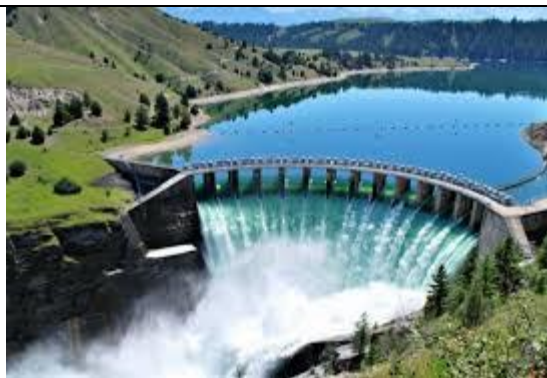
Υδροηλεκτρικό εργοστάσιο στην Ορεσιτιάδα.
