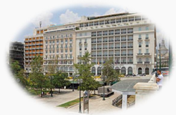
Τα τρία μεγάλα ξενοδοχεία που βρίσκονται στην βόρεια πλευρά της Πλατείας Συντάγματος
