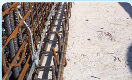
Εγκατάσταση θεμελιακής γείωσης
