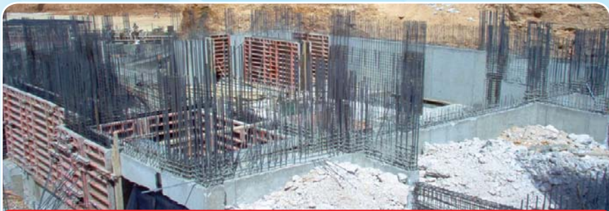
Πανοραμική εγκατάσταση θεμελιακής γείωσης
