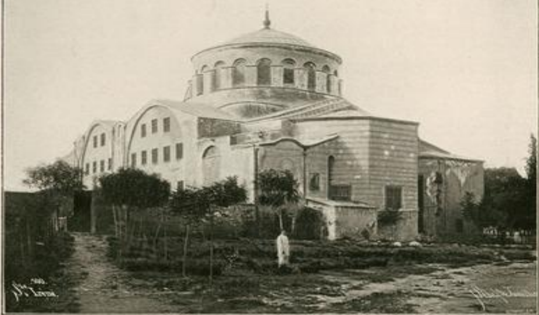
Eglise Sainte-Irène, actuellement transformée en Arsenal.
