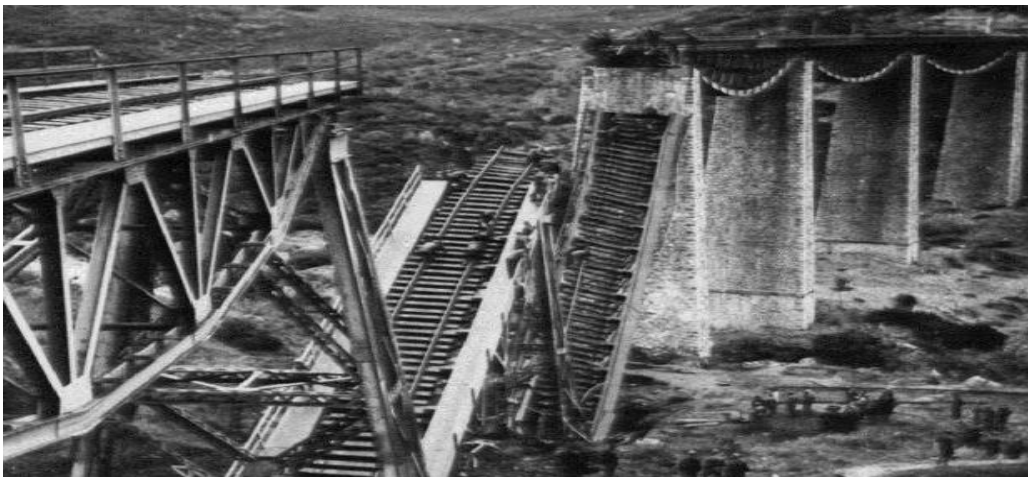
Η γέφυρα του Γοργοποτάμου μετά την ανατίναξη.
