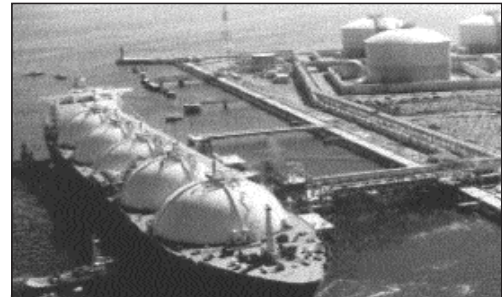
Εικόνα 7.1.7 Εγκαταστάσεις μεταφόρτωσης υγροποιημένου φυσικού αερίου στις ΗΠΑ
