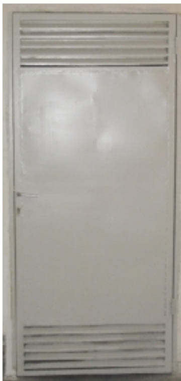
Σχέδιο 2.4 Θύρα μηχανοστασίου
