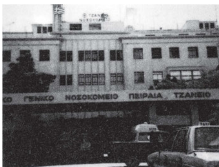
ΕΙΚΟΝΑ 6.1. Περιφερειακό Γενικό Νοσοκομείο Πειραιά «ΤΖΑΝΕΙΟ».
