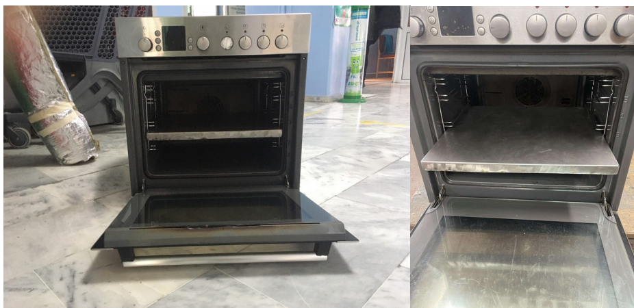
Εικόνες 9, 10: Φωτογραφίες μετά την τοποθέτηση του διαχωριστικού στο φούρνο Στην αριστερή φωτογραφία, στο βάθος διακρίνεται ένα ρολό πετροβάμβακα
