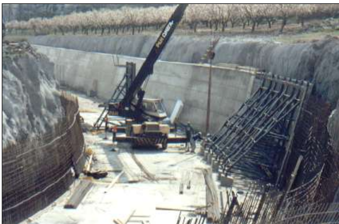
Συλλεκτήρας υπό κατασκευήν
