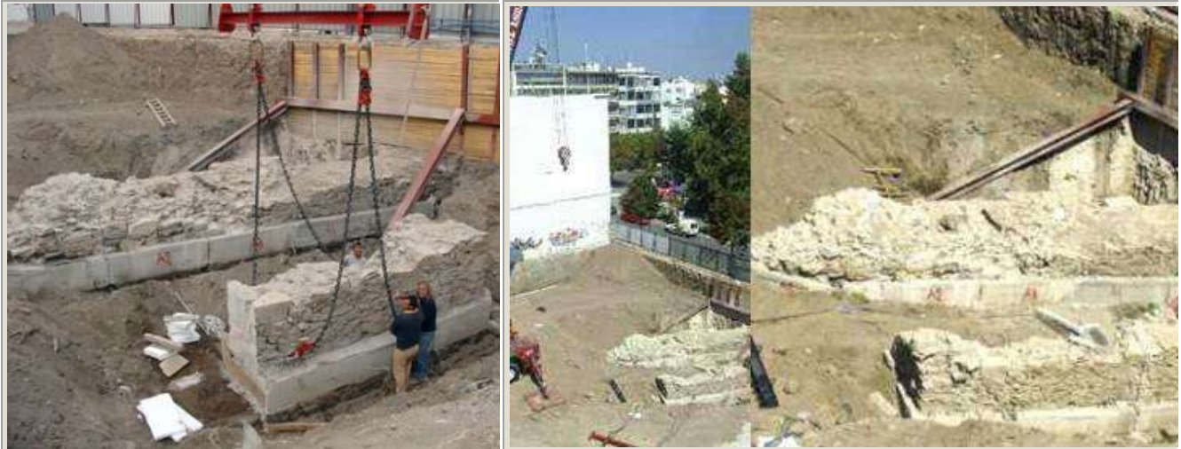
Εργασίες αποκατάστασης του τείχους
