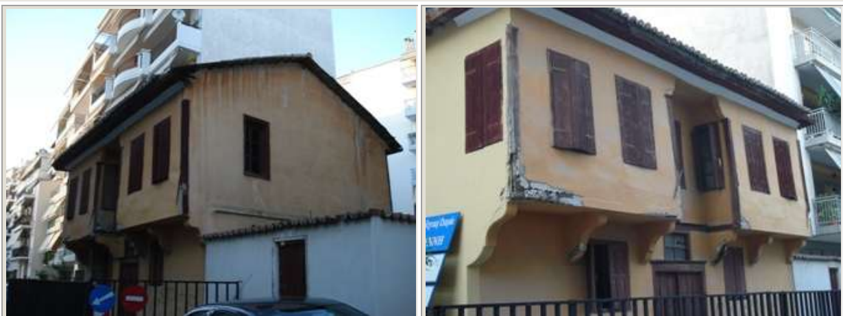
Όψη του διατηρητέου κτηρίου στην οδό Σεφέρη 39
