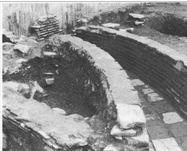
6. Δίκτυο κτιστών αποχετευτικών αγωγών.
