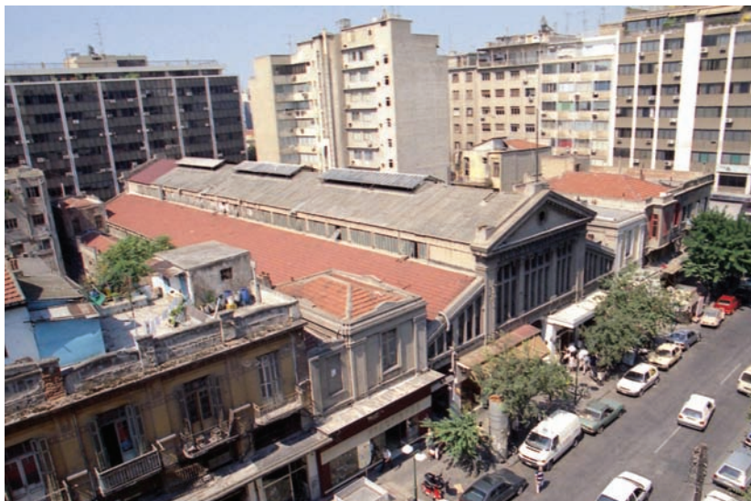
Το κτίριο της Στοάς Μοδιάνο, κεντρικής αγοράς τροφίμων Θεσσαλονίκης. The Stoa Modiano building, the city's main food market.
