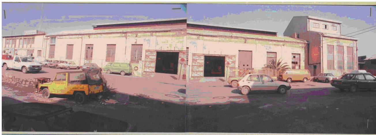
Απόψεις του κτιρίου της Παλιάς Ηλεκτρικής πριν κατεδαφιστεί
