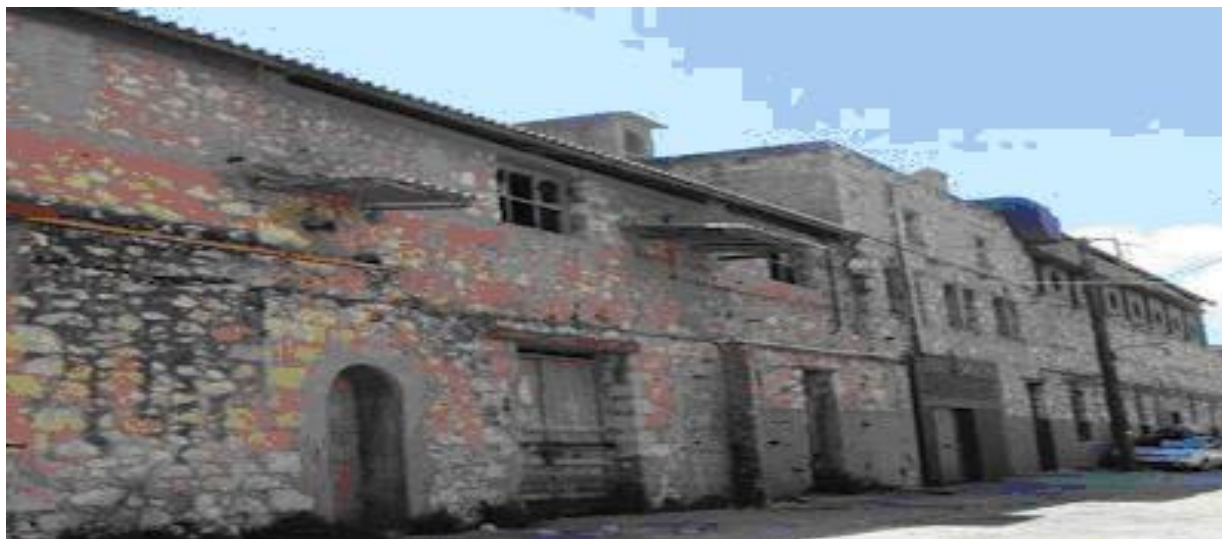
Άποψη του Εργοστασίου ΑΘΗΝΑ
