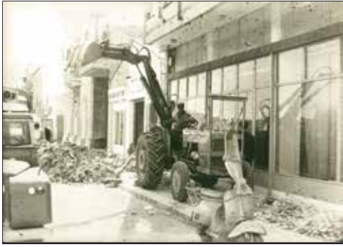
Συνεργείο τοποθετεί υπόγεια καλωδία στην προκυμαία
