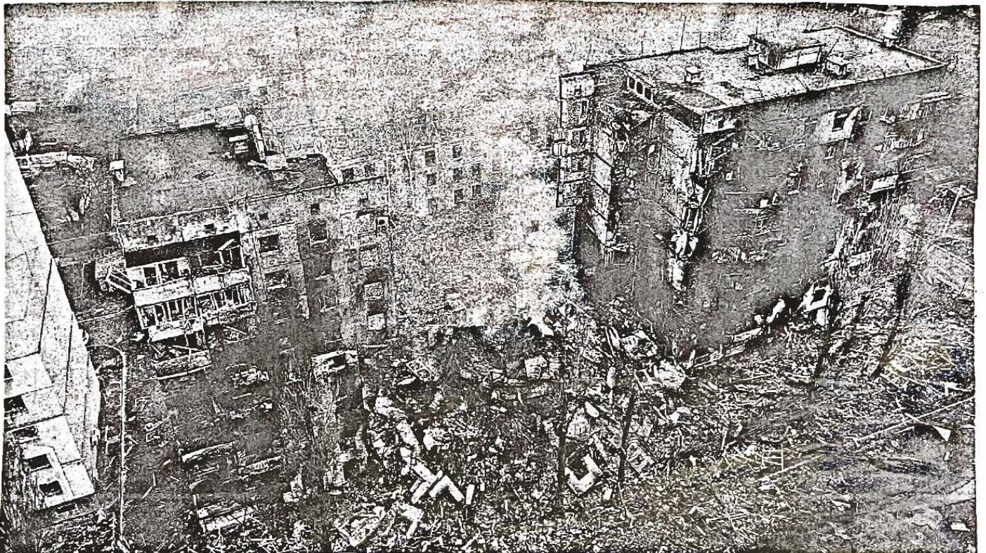
Αεροφωτογραφία δείχνει κατεστραμμένα κτίρια έπειτα από αδυσώπητο ρωσικό σφύροκόπημα στη γειτονιά Μποροντιάνκα στην περιοχή του Κιέβου. Πόλεις και χωριά της Ουκρανίας έχουν υποστεί ανυπολόγιστες ζημιές. Σελ. 5
