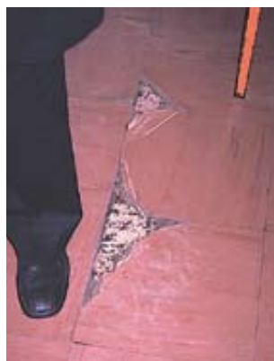
Ανασηκωμένα πλαστικά πλακάκια είναι συχνή αιτία πτώσης (Θεσσαλονίκη 2005).
