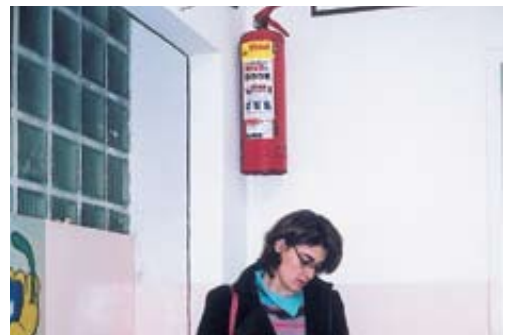
Πάρα πολύ ψηλά τοποθετημένος πυροσβεστήρας (σχολείο Θεσσαλονίκης 2005).
