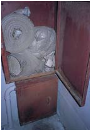
Δεν αρκεί μόνο η ύπαρξη πυροσβεστικού σημείου. Θα πρέπει να είναι και χρησιμοποιήσιμο.
