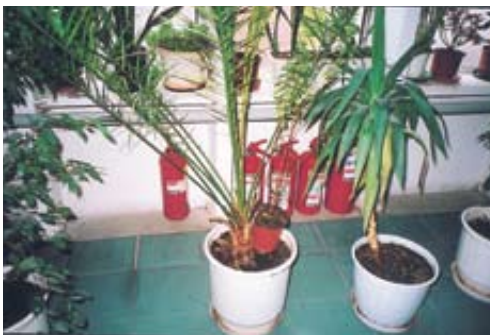
Οι πυροσβεστήρες δεν πρέπει να είναι συγκεντρωμένοι σε ένα σημείο (Θεσσαλονίκη 2005).
