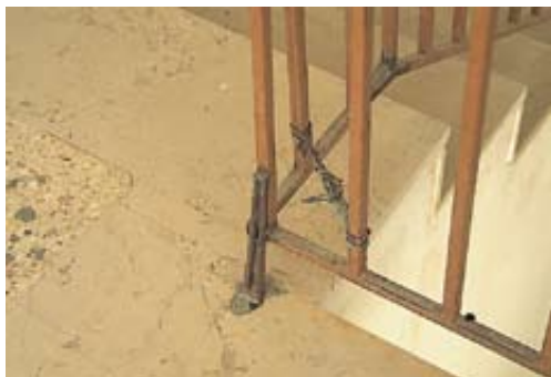
Πολύ αδύνατη κατασκευή και πολύ πρόχειρη επισκευή!
