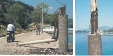
Ο σεισμός στο Αίγιο Πελοποννήσου (1994) δεν ήταν η αιτία πτώσης της κολώνας (αριστερά), αλλά η πολύ κακή συντήρησή της (δεξιά - προ σεισμού).
