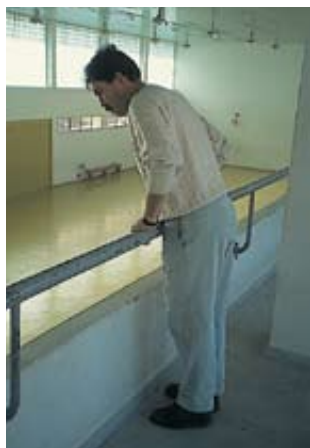
Χαμηλό κιγκλίδωμα στον εξώστη κλειστού γυμναστηρίου σχολείου.
