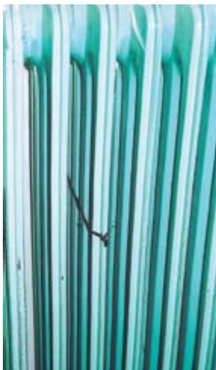
Πρόχειρη και επικίνδυνη συγκράτηση σώματος καλοριφέρ (Θεσσαλονίκη 2005).
