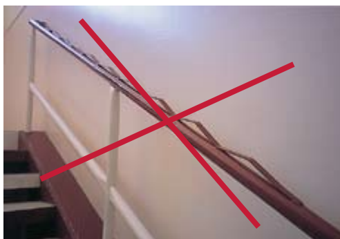
Ακατάλληλος και επικίνδυνος τρόπος παρεμπόδισης τσουλήθρας (πιάνονται και τραυματίζονται δάκτυλα) (Θεσσαλονίκη 2005).
