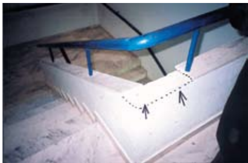
Τα μάρμαρα (βέλη) απαιτούν καλή στήριξη με ειδικές βίδες - όχι κολλητά (Θεσσαλονίκη 2005).
