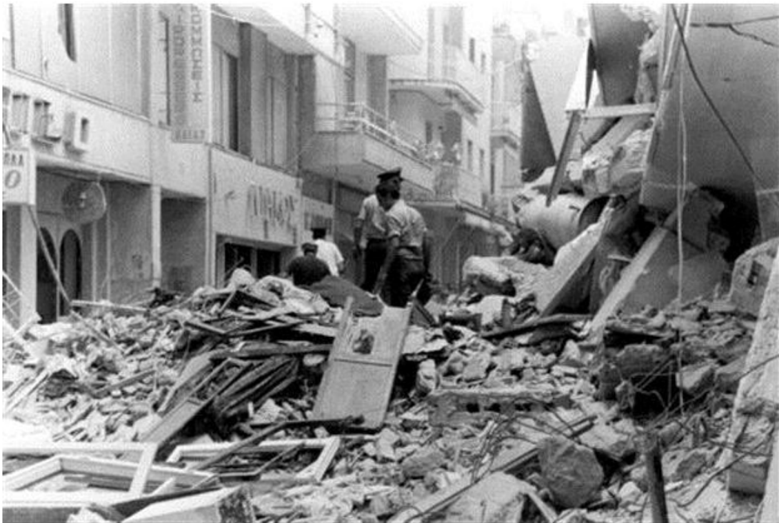
Ο σεισμος του 1978 απέδειξε ότι και το οπλισμένο σκυρόδεμα γνωστότερο ως μπετόν, δεν παρέχει πλήρη ασφάλεια.
