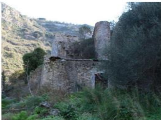
Νερόμυλος με εσωτερική φτερωτή στους Κάτω Αστρακούς Ηρακλείου Κρήτης
