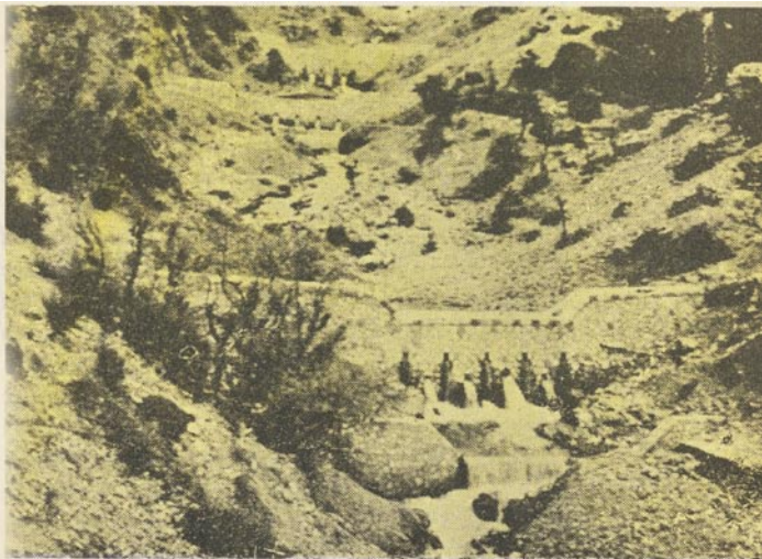
55. Ἔργα στερεώσεως ἔδαφῶν, ἀναδασώσεις καὶ ἀνασχετικά φράγματα εἰς τὴν λεκάνην τοῦ ὄρειου χειμάρρου Γλάκου παρὰ τὰς Πάτρας.
