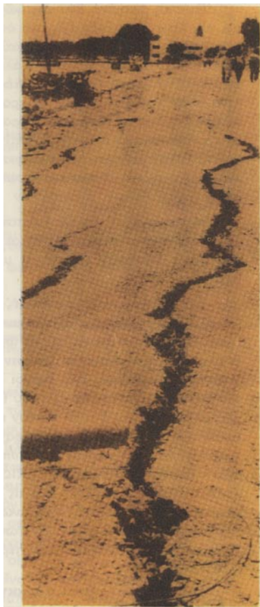
108. Σεισμογενὴς ρωγμὴ σχηματισθεῖσα εἰς τὸ ἔδαφος τῆς πόλεως Ζακύνθου κατὰ τοὺς σεισμούς 9 ἕως 12 Αὐγούστου 1953.
