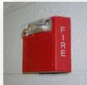
Εικόνα 62. Σύστημα ειδοποίησης πυρκαγιάς (Δημουλά, κ.ά., 2023)
