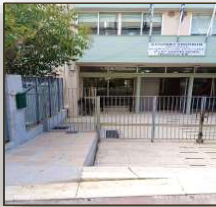
Εικόνα 7: Προσβάσιμη είσοδος σχολείου(σκάλα και ράμπα) (9 ο Δημοτικό σχολείο & 10 ο Δημοτικό σχολείο Ηρακλείου Αττικής)
