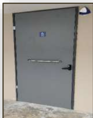
Εικόνα 182. Πόρτα με πόμολο και μπάρα (1° ΕΠΑ.Λ. Κέρκυρας)
