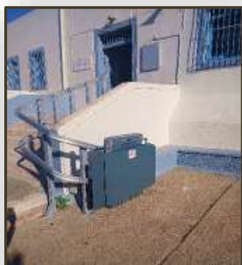
Εικόνα 95. Αναβατόριο κλίμακας με πλατφόρμα (3 ο Γυμνάσιο Καλύμνου)
