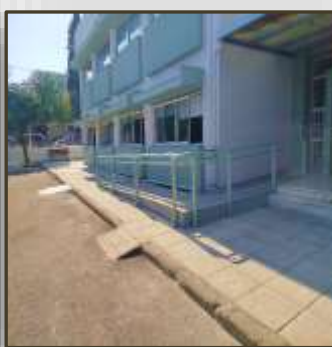
Εικόνα 9. Ράμπα παράλληλα στο κτίριο (4 ο Δημοτικό σχολείο Κω)
