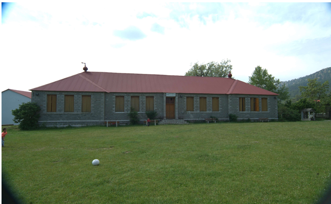
(Εικ.3 η : Το Δημοτικό Σχολείο Σαμαρίνας. Χτίστηκε μάλλον το 1910.)
