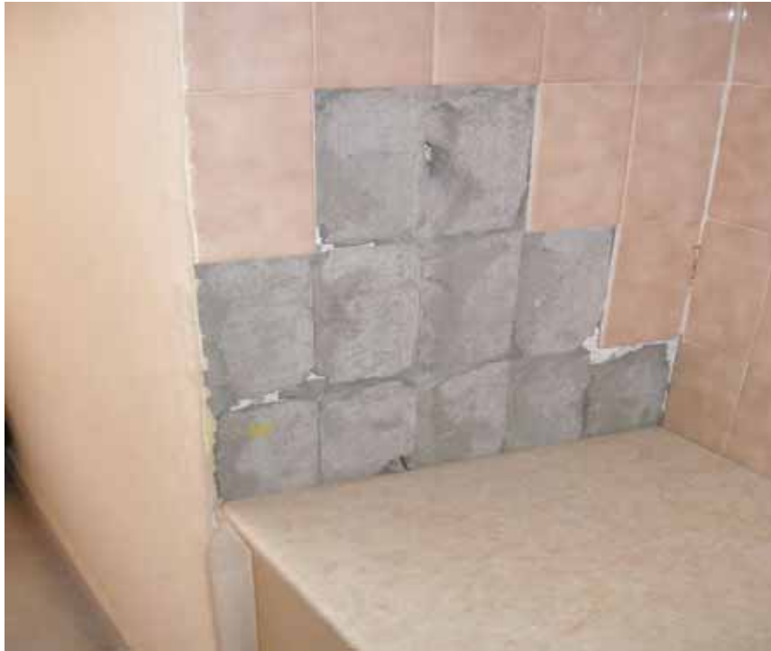
Φωτ: 10:Συμπλήρωση πλακιδίων στις εσωτερικές βρύσες των ορόφων.
