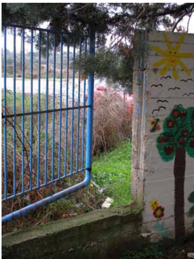
Φωτ.7 :Επιδιόρθωση μεταλλικών στοιχείων περίφραξης.
