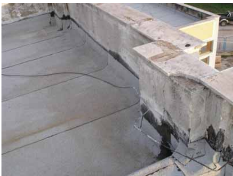
Φωτ.8: Επισκευή και έλεγχος αλεξικέρανου.
