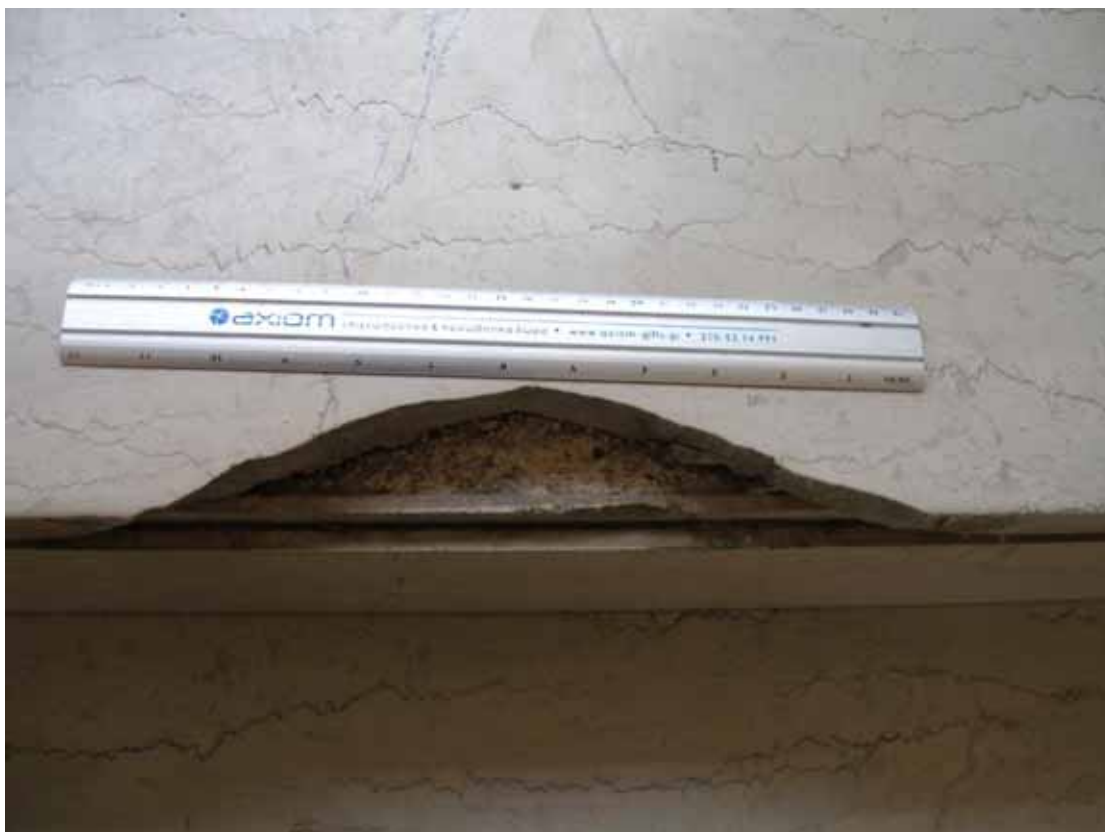
Φωτ.4: Επισκευή και αντιολισθητική ταινία σκαλοπατιών.
