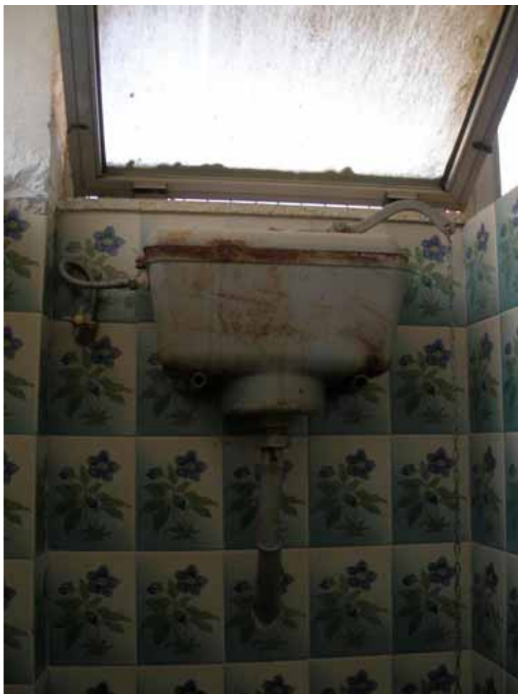
Φωτ.9: Ανακαίνιση τουαλετών
