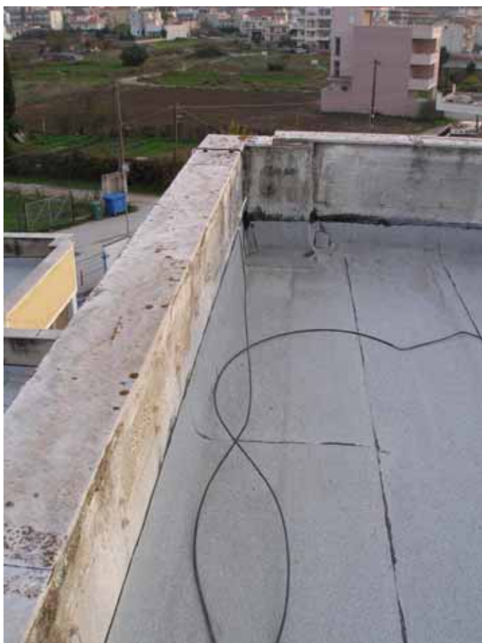
Φωτ.8:Επισκευή και έλεγχος αλεξικέρανου.
