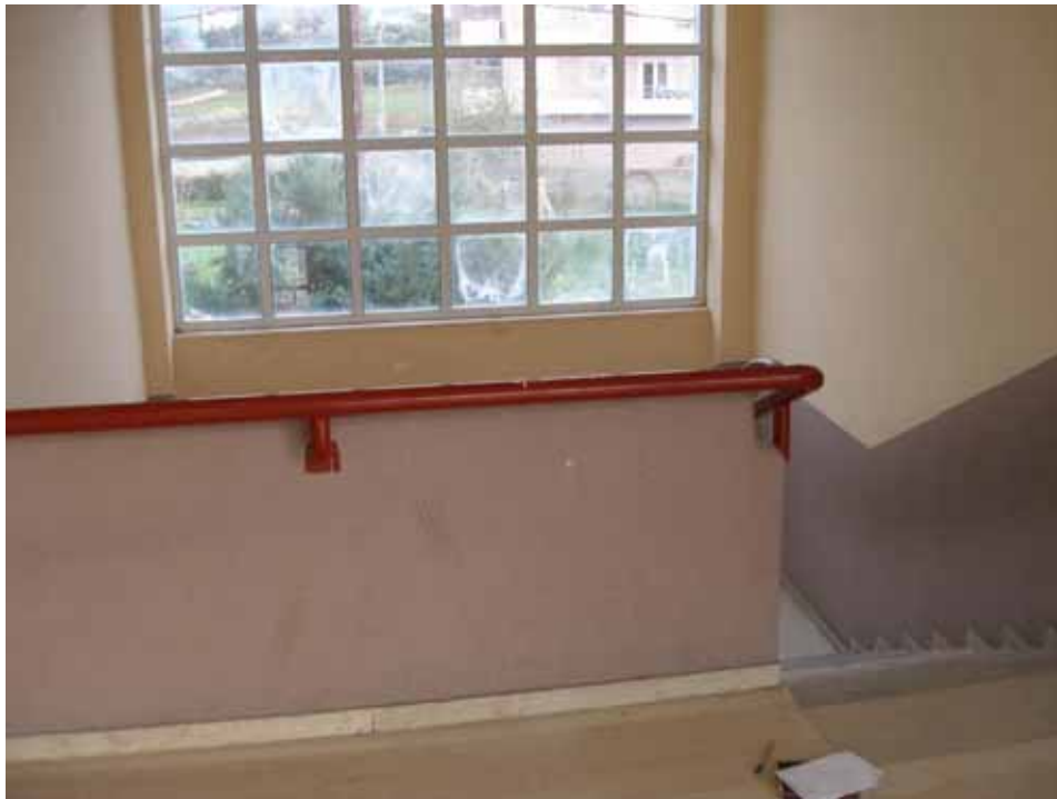
Φωτ.6: Ανύψωση υφιστάμενης κουπαστής στηθαίου.
