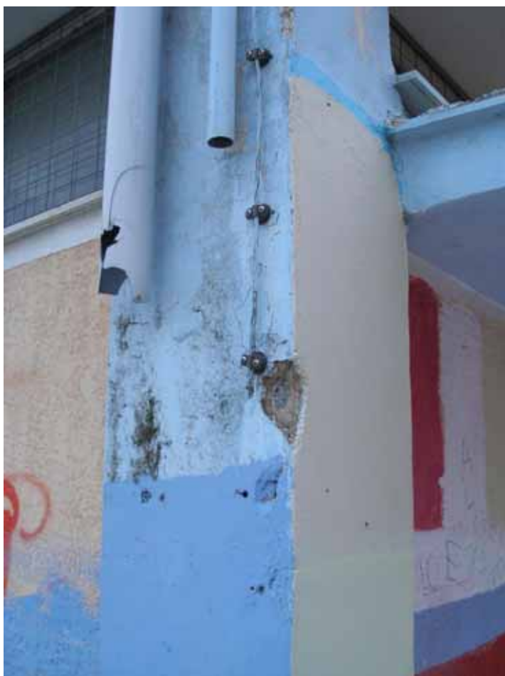
Φωτ.8 :Αντικατάσταση γείωσης αλεξικέρανου.
