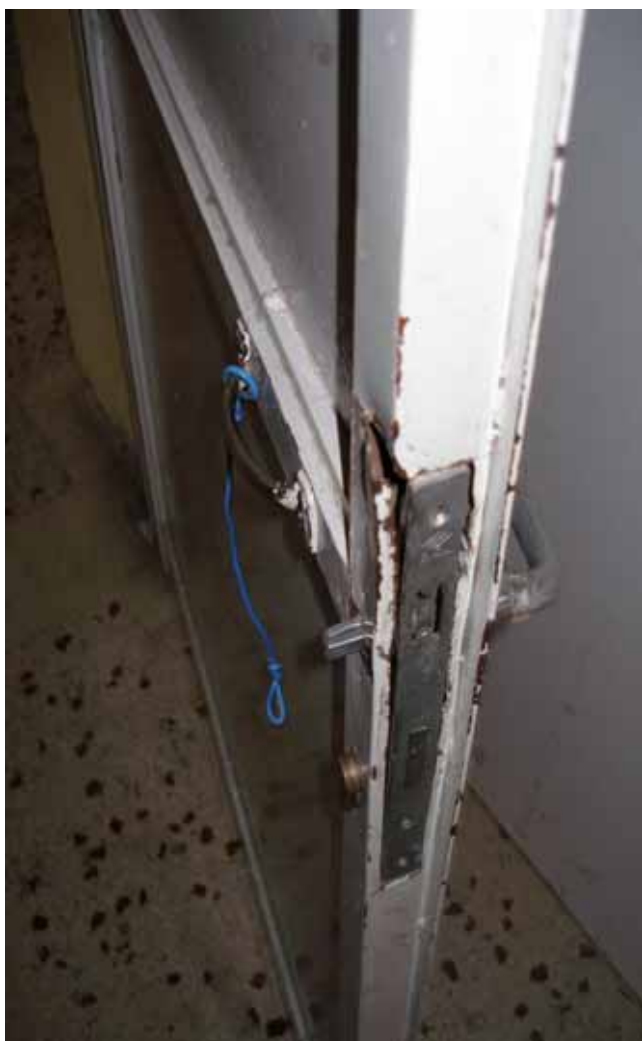
Φωτ.11: Επίσκεψη κασωμάτων και αντικατάσταση κλειδαριών.
