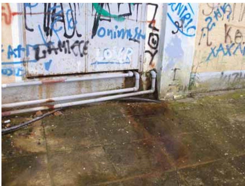
Φωτ.12: Έλεγχος και επισκευή διαρροών κεντρικών σωλήνων ύδρευσης.
