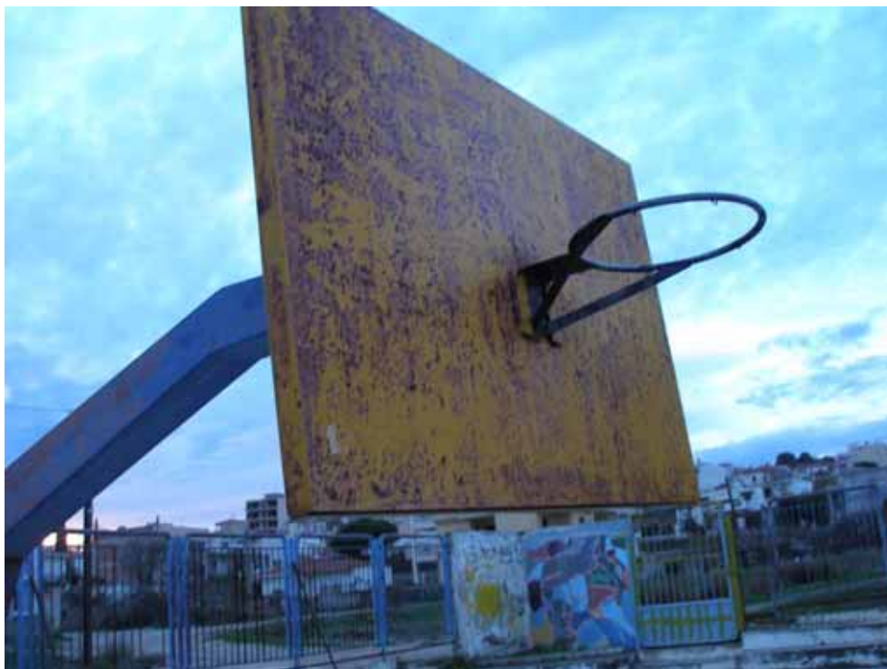
Φωτ.3: Αντικατάσταση μπασκετών.
