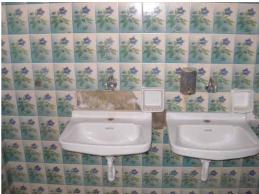
Φωτ.9: Ανακαίνιση τουαλετών
