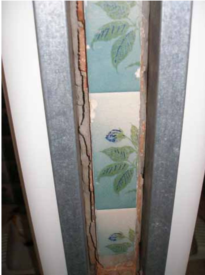
Φωτ.9: Ανακαίνιση τουαλετών
