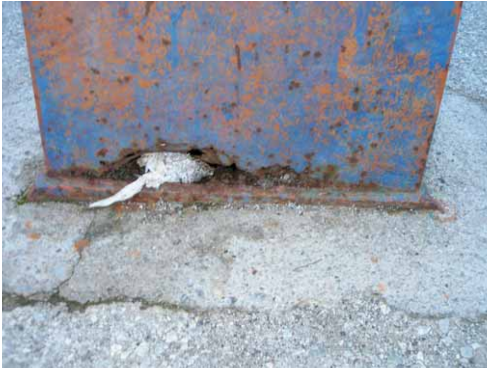
Φωτ.3: Αντικατάσταση μπασκετών.
