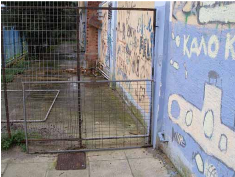
Φωτ.7 :Επιδιόρθωση πλέγματος-πόρτας εσωτερικής περιφράξης.
