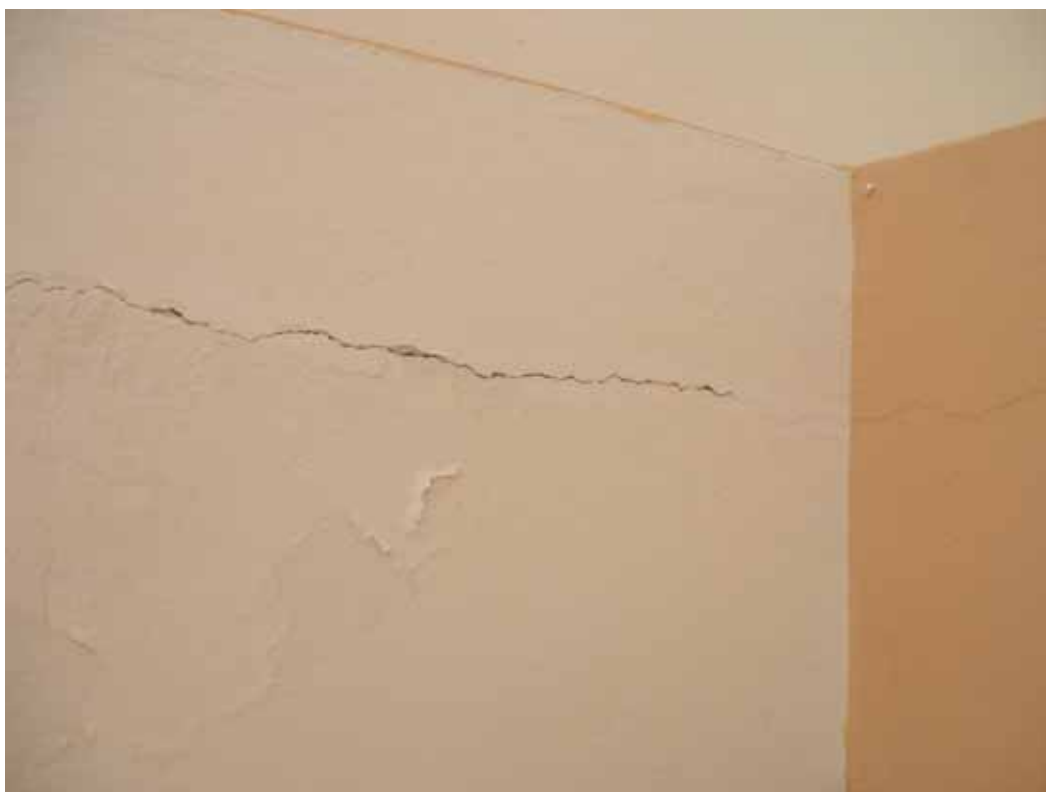
Φωτ.13:Έλεγχος και αποκατάσταση ρωγμών δομικών στοιχείων λόγω καθίζησης.
