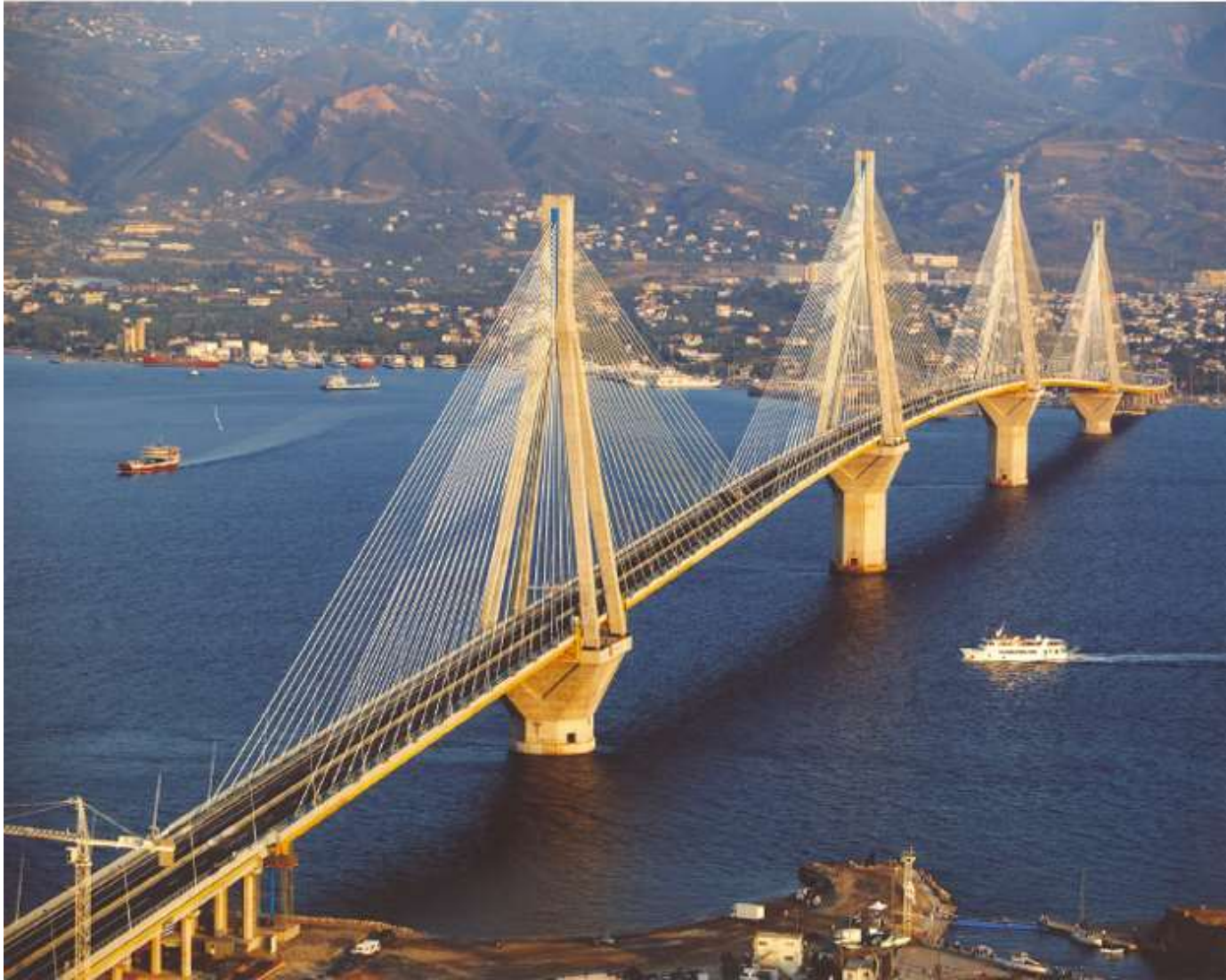
Η γέφυρα Ρίου-Αντιρρίου που φέρει το όνομα «Χαρίλαος Τρικούπης»
