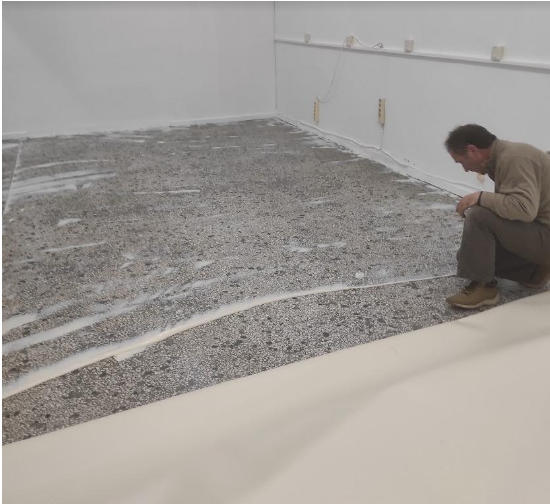
Στρώσιμο εργαστηρίου πληροφορικής με αντιστατικό δάπεδο
