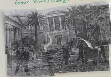
Γίνεται πόλεμος, σκάνε βομβές που πέσαν έχουν χιονί (Γιώργος Κ., Ηλίας)
