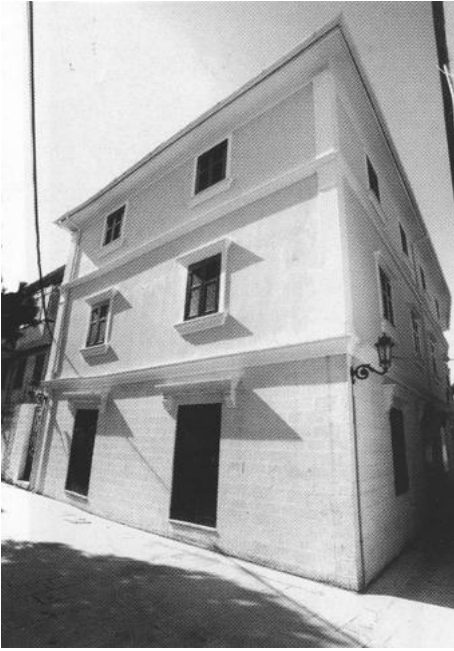
Οικία Κόνδαρη, στην οδό Κόνταρη (τώρα ανακατασκευασμένη στεγάζει τη Φιλαρμονική Λευκάδας). Στην παλαιά οικία στεγάστηκε το Ελληνικό Σχολείο (1919-1922, 1923-1929). Φωτογραφία Δ. Βλάχου (2002).
